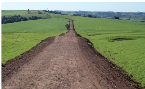
Figura 18. Estrada rural adequada na região oeste do Paraná: leito abaulado possibilita escoamento da água para os lados; terraços interceptam a estrada, “retirando” água da estrada; ensaibramento (revestimento) da estrada possibilita tráfego mesmo em dia de chuva. Foto: Jeferson Dieckow.
