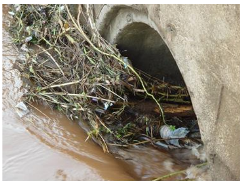
Figura 20. Enxurrada na cidade de Maringá (PR), na qual se observa a elevada quantidade de resíduos sendo transportado para o bueiro. Foto: arquivo do Instituto EMATER.
