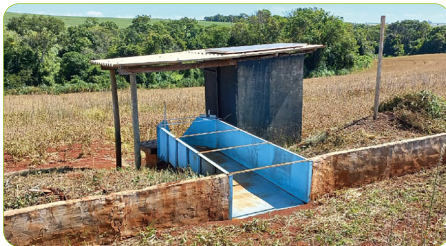
Figura 4 – Calha H instalada em uma megaparcela na bacia hidrográfica de Cambé-PR
