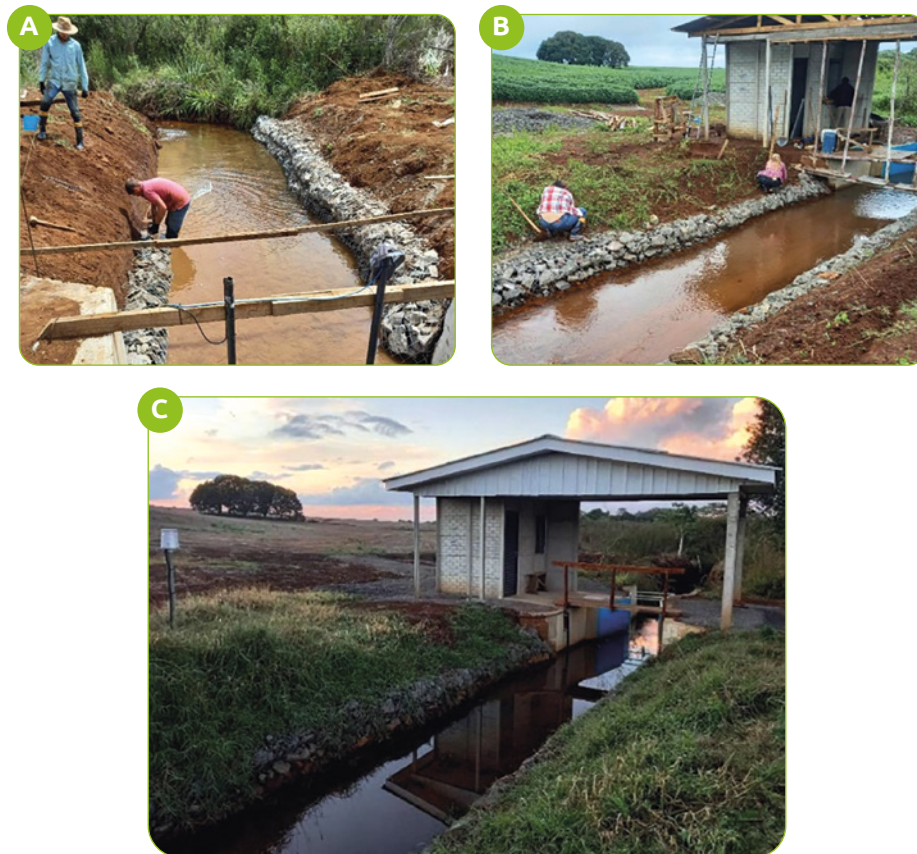
Figura 8 – Adequação das instalações junto à calha Parshall, em Guarapuava-PR
