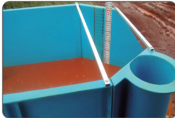
Figura 24 – Régua linimétrica instalada na calha H da seção de monitoramento hidrossedimentométrico de uma megaparcela da bacia hidrográfica de Cambé-PR Fonte: Grupo de Pesquisa em Ciência do Solo – IDR-Paraná (2022).
