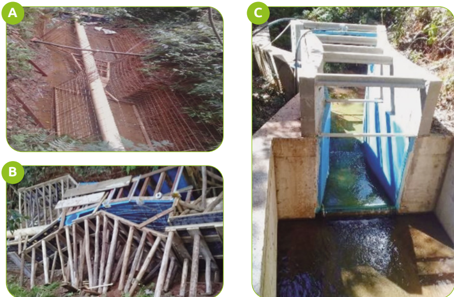
Figura 5 – Etapas de construção da calha Parshall na bacia hidrográfica de Toledo-PR
