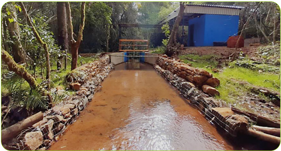
Figura 7 – Área de aproximação dos escoamentos de entrada na calha Parshall, na bacia hidrográfica de Dois Vizinhos-PR
