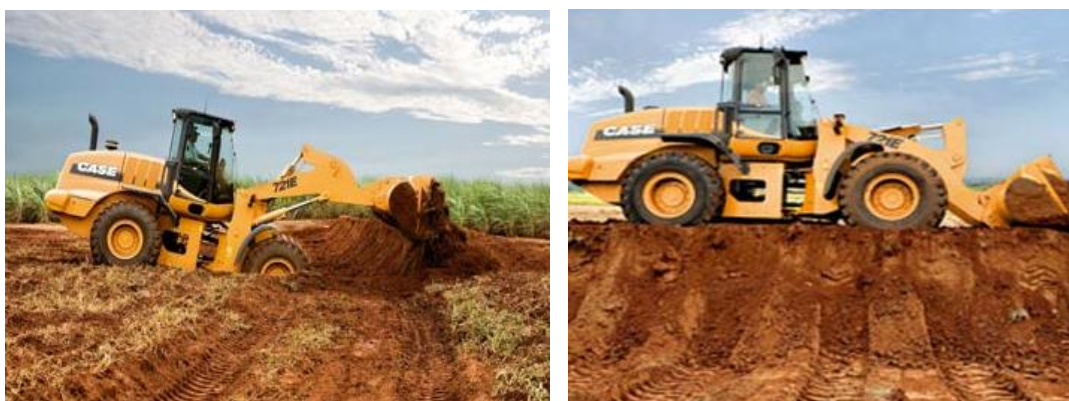
Figura 1. Pá carregadeira movimentando o solo durante a construção e manutenção de terraço de infiltração em área de plantio de cana-de-açúcar.
