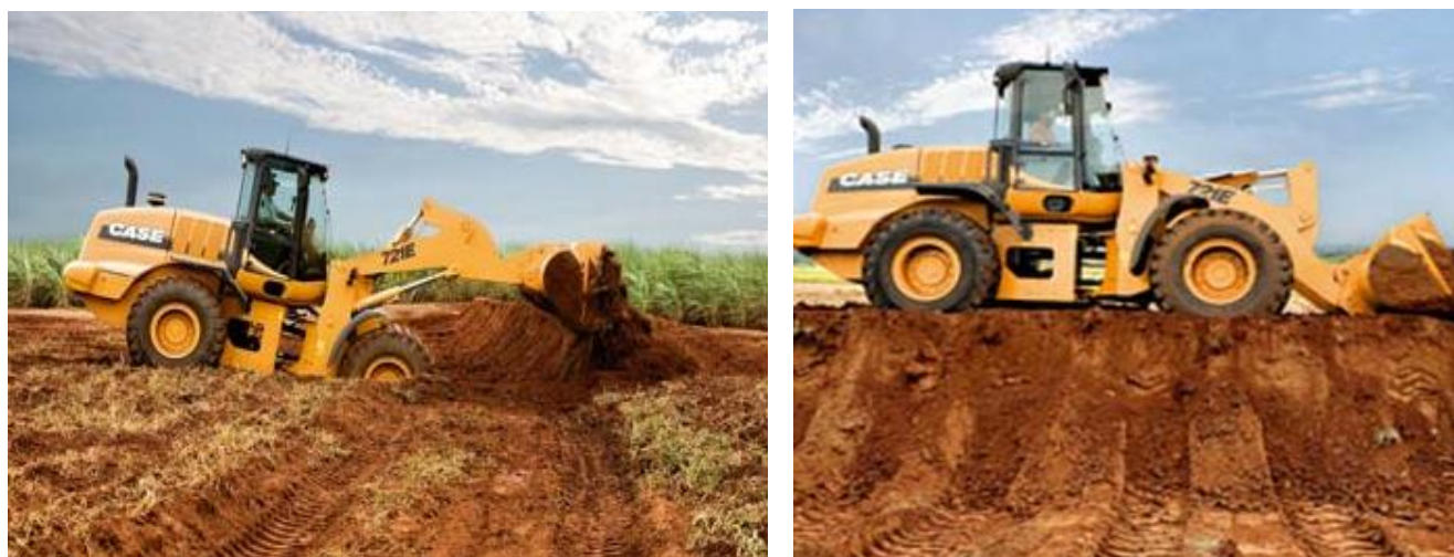
Figura 1. Pá carregadeira movimentando o solo durante a construção e manutenção de terraço de infiltração em área de plantio de cana-de-açúcar.
