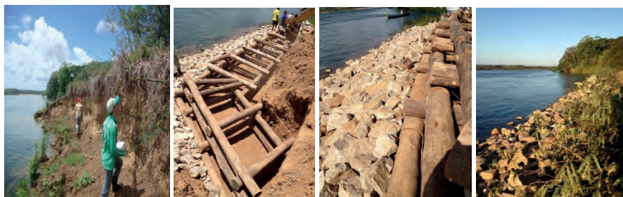
Figura 4. Talude verticalizado em processo erosivo e etapas de implantação da técnica de Parede Krainer.
