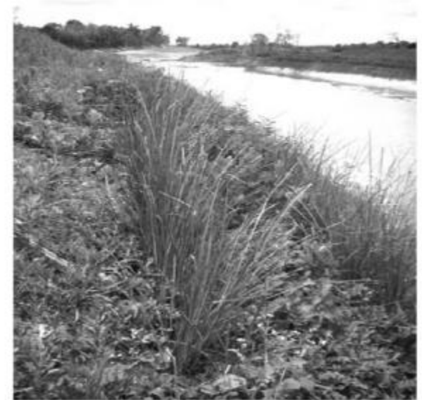
Foto 3 – Proteção de margens de curso d'água com barreiras vivas de vetiver em consorciação com gramíneas e leguminosas e biomanta antierosiva de proteção definitiva.
