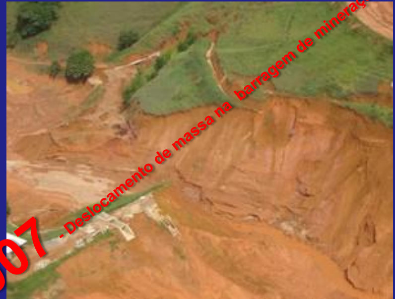
2003 - Deslocamento de massa na barragem, Cataguases (MG).
