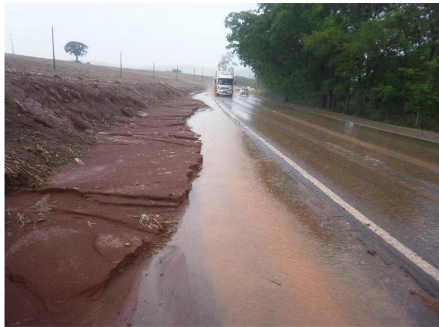
Influência: Em rodovias - Distribuição de águas pluviais e sedimentos sobre a via.
