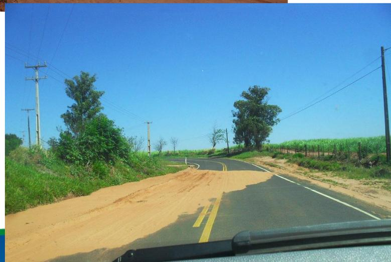
Influência: Em rodovias - Distribuição de águas pluviais sem o adequado tratamento. (Contenção necessária).
