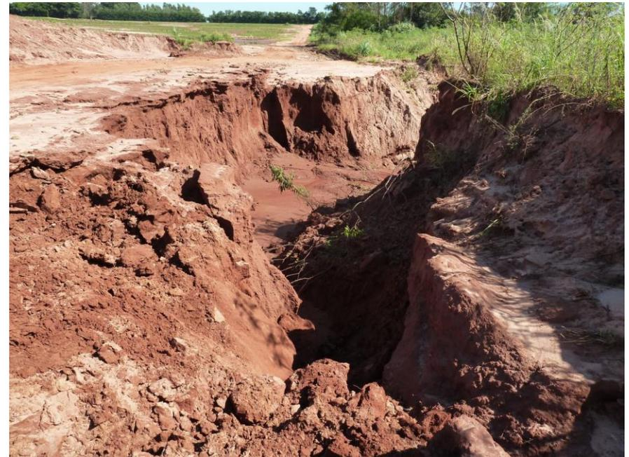
Estradas - manejo de distribuição de águas pluviais. ??
