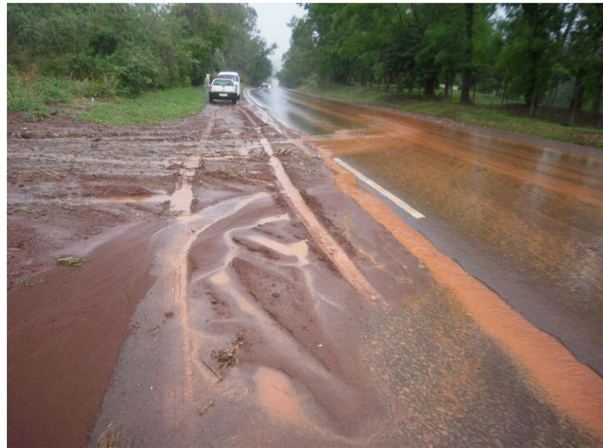
Influência: Em rodovias - Distribuição de águas pluviais sem o adequado tratamento, oriundo e **carreadores de acesso** Propriedade rural à montante sem sistema de conservação de solos.
