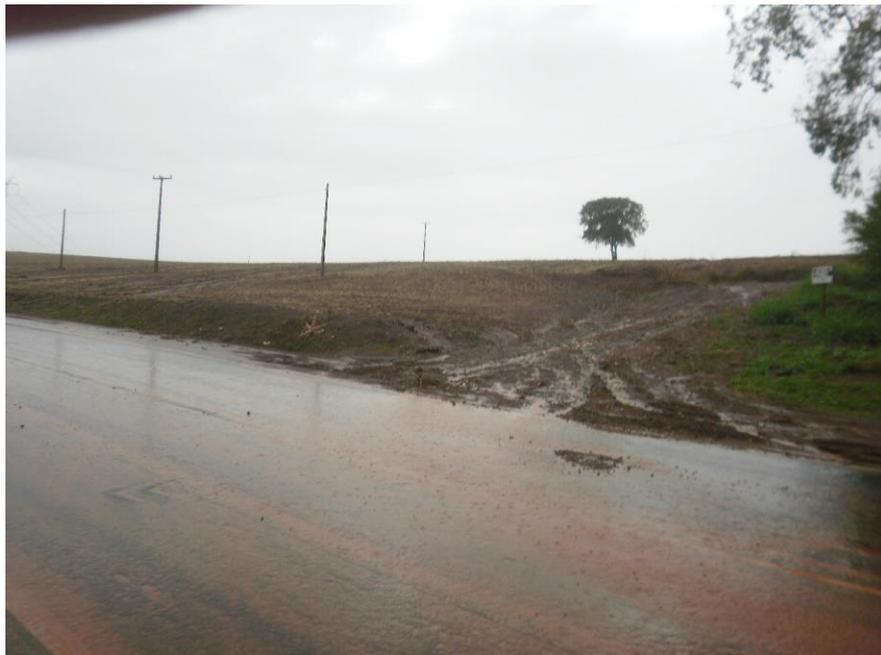
BR's e PR's – Influência hídrica – escoamento superficial de águas pluviais por meio de **carreadores de acesso** às propriedades, sem sistema adequado de condução de águas, direcionando para o pavimento das rodovias.
