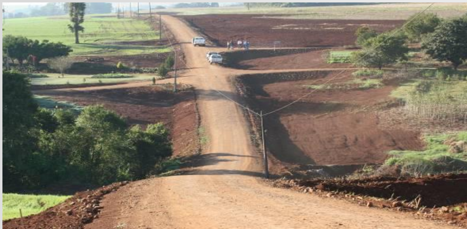
Adequação de estradas rurais
